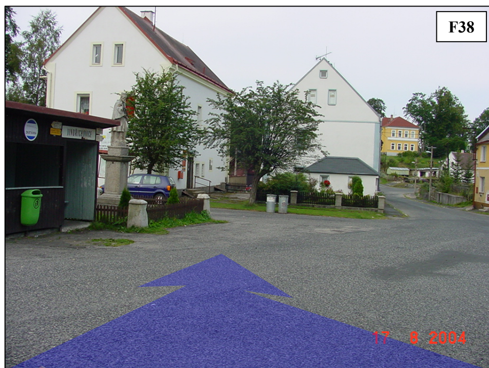
Ohrožené objekty ve středu obce, v pozadí budova Pošty.
