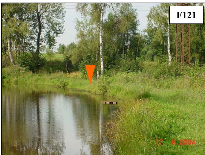
Pohled na hrázi s označením nejnižšího bodu, kde voda přetéká přes hrázi.
