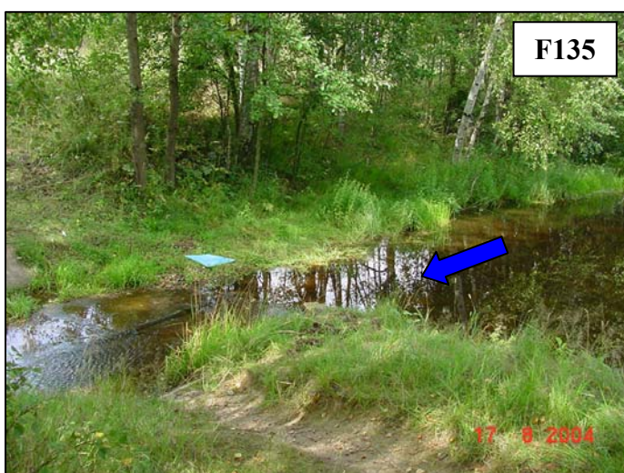
V levé části hráze je vybudován bezpečnostní přeliv.
