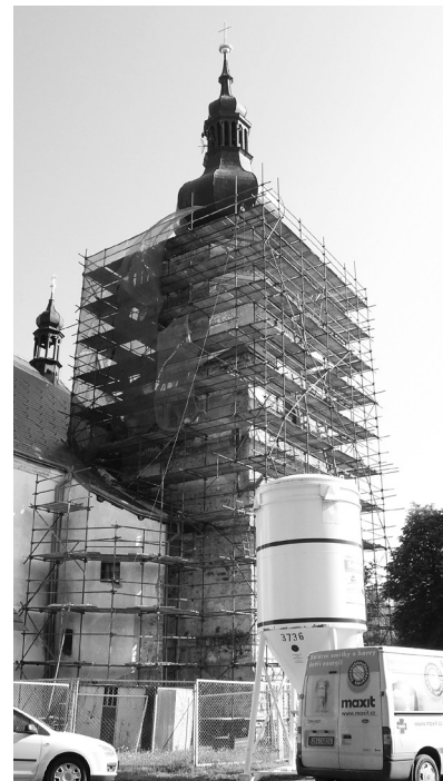
Lešenářské trubky zakryly v srpnu věž kostela v Jindřichovicích. Oprava věže, která si vyžádá nemalé finanční prostředky, má být hotova letos do konce října.
